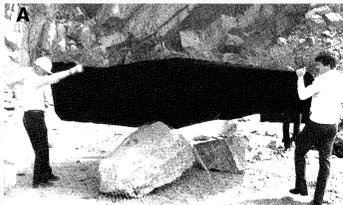
**1.2.** Aufgrund der hohen Ladebrisanz wurden bei dieser Bunkersprengung (2 m mächtiger Stahlbeton) in einem Wohngebiet unter Dynastat UV noch Strohballen als zusätzlicher Schutz verwendet.
